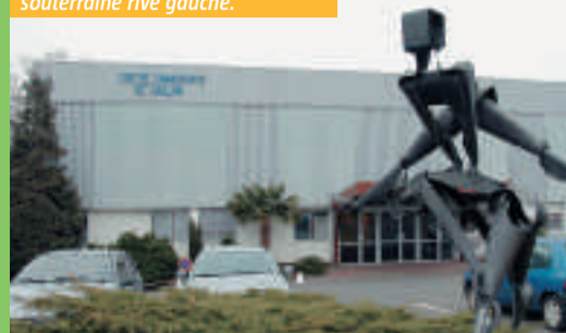
Gymnase Gaillon : rénovation intérieure prévue.
