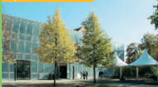
La cour du lycée International.
