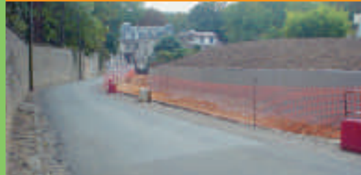
Les travaux ont commencé Chemin de l'Aqueduc à Louveciennes.
