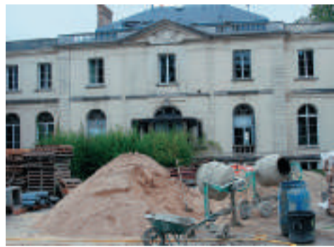
Visite du chantier en septembre 2009.
