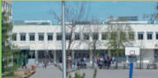
Collège François-Mauriac (Houdan) : à la demande de Jean-Marie Tétart, les équipements techniques installés en toiture seront prochainement dissimulés.
